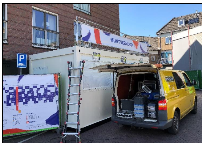
Mobiele stroom voor de monteurs
